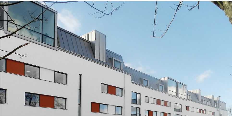
Egebjerg, efter renovering: Facader er efterisoleret og det arkitektoniske udtryk er forandret
