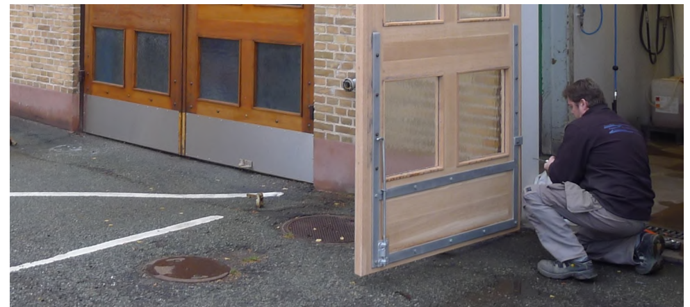
Brandstation, tilbageføring og rekonstruktion af porte
